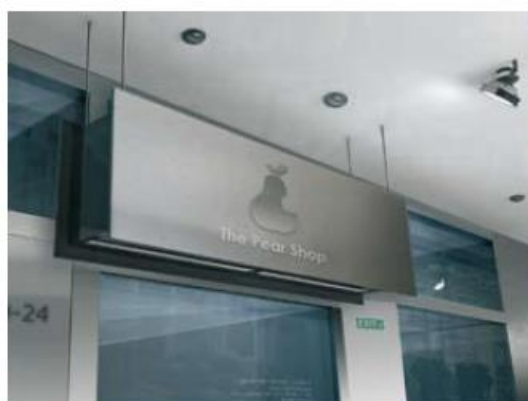
Przykład instalacji kurtyny ZEN M 1500 E na zawieszach pod sufitem.
